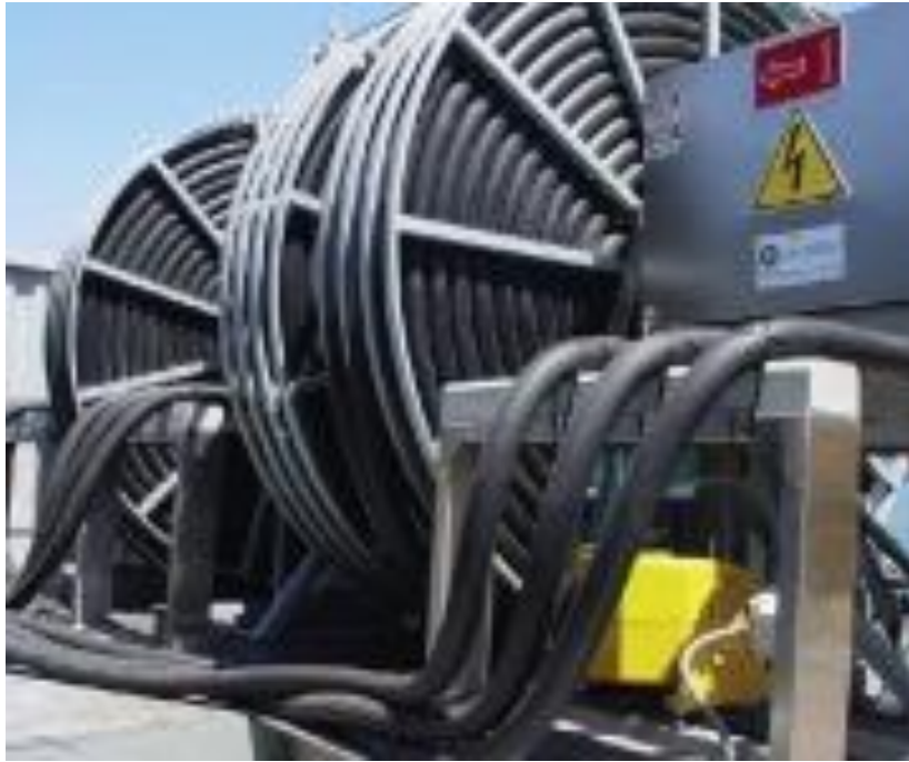
Εικόνα 82 Καλώδια coldironing
